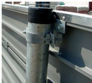
Fot. 1.13. Tablica zamontowana do słupka – widok od strony ząbka
