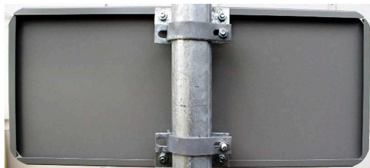
Fot. 1.7. Uchwyt typu „Zacisk” zamocowany do krawędzi tablicy
