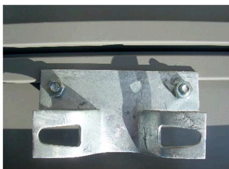
Fot. 1.12. Uchwyt zamocowany do profilu montażowo-usztywniającego
