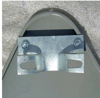
Fot. 1.3. Uchwyt typu „Zacisk” zamocowany do znaku trójkątnego
