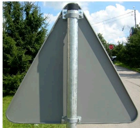
Fot. 1.6. Uchwyt typu „Zacisk” zamocowany do krawędzi znaku
