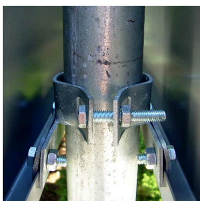
Fot. 1.23. Tablica dwustronna zamontowana do słupka – widok z boku
