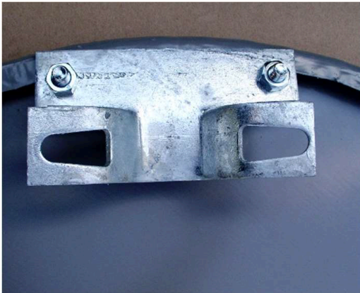
Fot. 1.2. Uchwyt typu „Zacisk” zamocowany do znaku okrągłego
