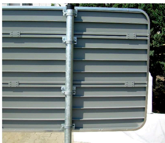
Fot. 1.15. i 1.16. Tablica zamontowana do słupka za pomocą uchwytów typu „Zacisk”
