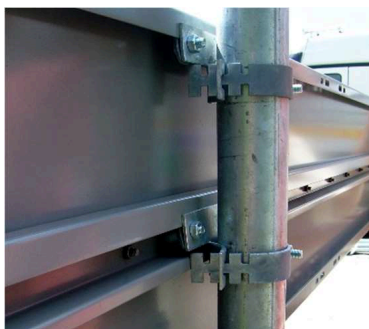
Fot. 1.9. Uchwyt typu „Zacisk” zamocowany do tablicy – widok od strony ząbka
