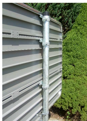
Fot. 1.15. i 1.16. Tablica zamontowana do słupka za pomocą uchwytów typu „Zacisk”
