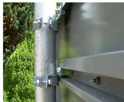
Fot. 1.10. Uchwyt typu „Zacisk” zamocowany do tablicy – widok od strony śruby
