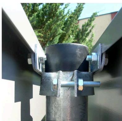
Fot. 1.22. Tablica dwustronna zamontowana do słupka – widok z boku
