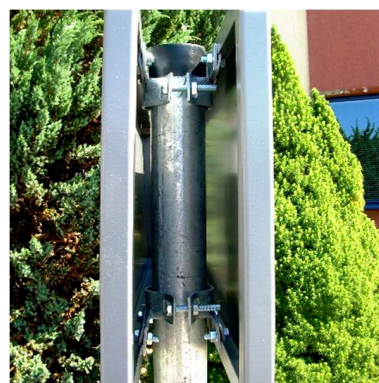
Fot. 1.21. Tablica dwustronna zamontowana do słupka – widok z boku
